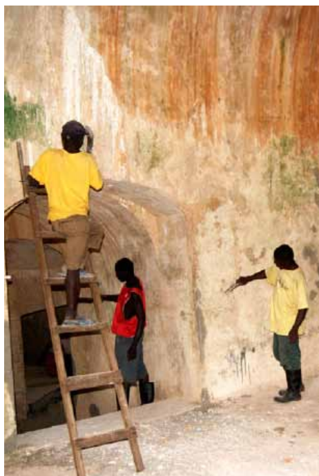
• Travaux de ravalement des murs et des voûtes
