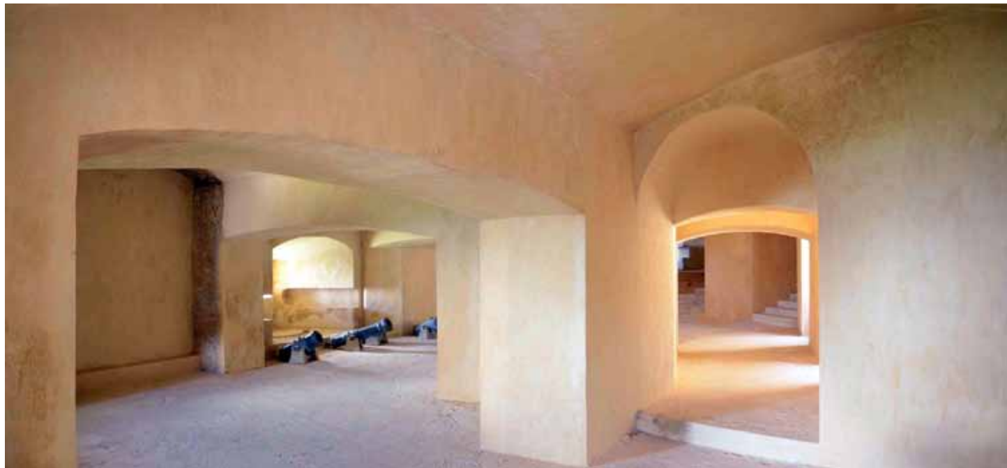
• Les salles de tir de la Batterie des Princesses avant et après les travaux de restauration
