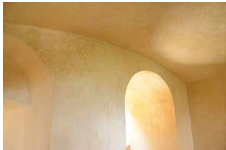
• Murs et voûtes après badigeonnage au lait de chaux pigmenté de terre ocre
